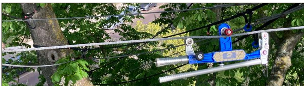
Prise des valeurs sur ancien câble à l'aide d'un tensiomètre
